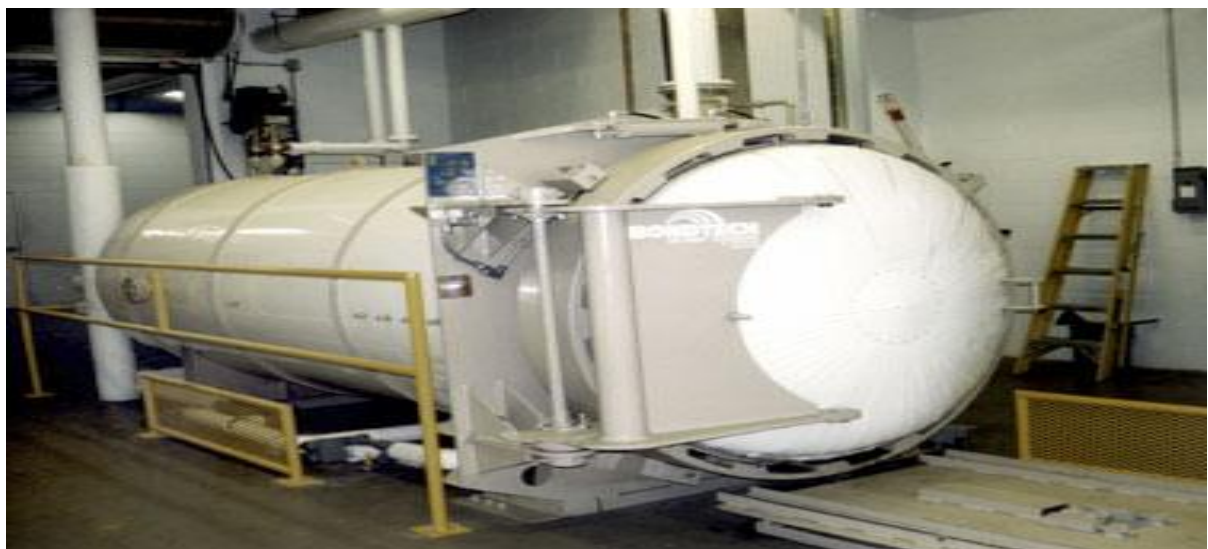
Κλίβανος αποστείρωσης μολυσματικών αποβλήτων
