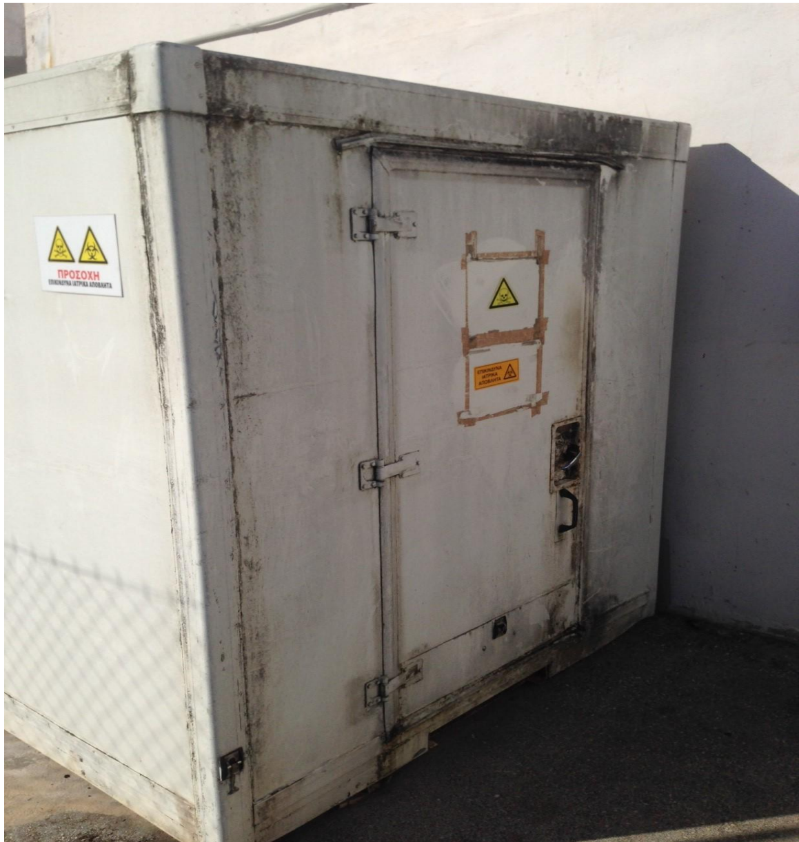
Εικόνα 14: Ψυκτικός θάλαμος προσωρινής αποθήκευσης ΜΕΑ
