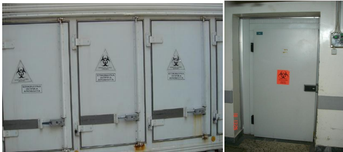
Ψυκτικοί θάλαμοι προσωρινής αποθήκευσης ΕΙΑ
